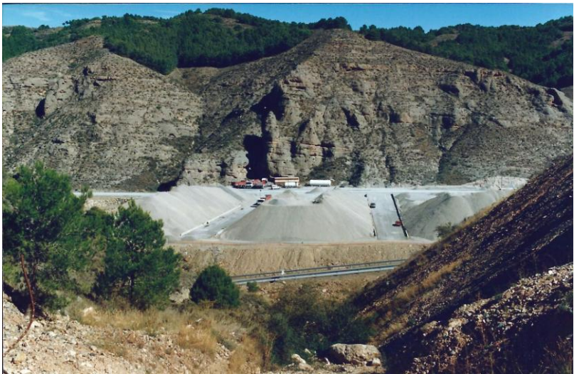
Přehrada Val ve výstavbě. Pohled na stavební dvůr a tříděné konstrukční materiály pro výrobu betonové směsi. Foto Otto Horský 1996.
