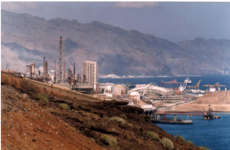
Studie kontaminace zemin znečištěných ropnými produkty a návrh dekontaminace v oblasti rafinerie v Santa Cruz na Tenerife realizoval Geotest Brno ve spolupráci s Geinzou, S.L. Foto Otto Horský 1994.
