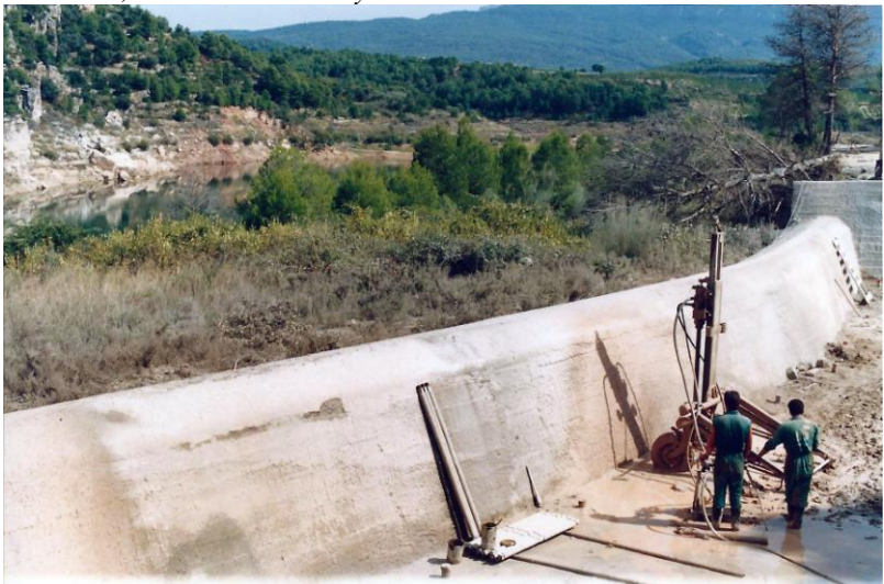
Provádění injekčních prací na přehradě Guiamets-Falset na řece Asmat v provincii Tarragona s cílem snížení průsaků pod hrází. Foto Otto Horský, 1996.
