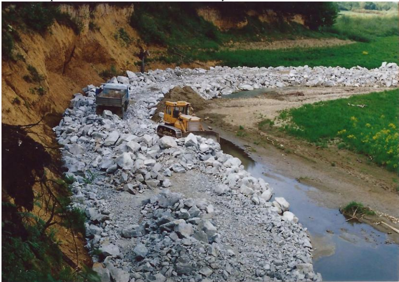
Sanace břehové linie kamenným záhozem jako opatření proti vlnbití. Stav 1996.
