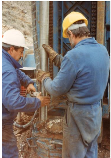
Geotechnický dozor při provádění vodních tlakových zkoušek propustnosti při výstavbě přehrady Val u Tarrazony, provincie Zarragoza. Foto Otto Horský, 1993.
