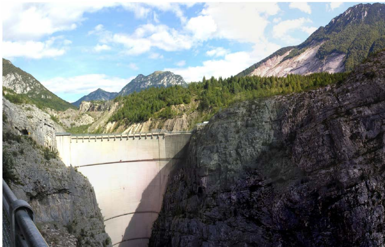
Obr. 2.3.31 Vajont - pohled na hrázi, sesuv a smykovou plochu (foto P. Bláha 2007)
