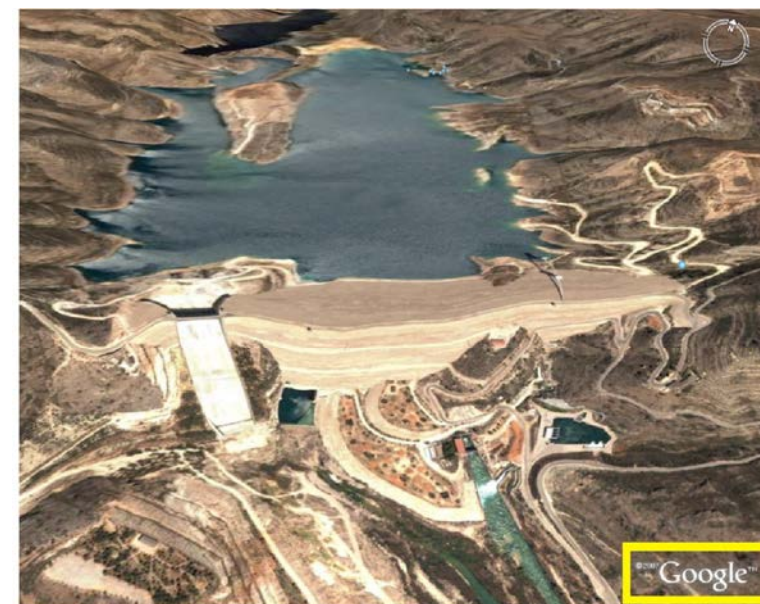
Obr. 2.3.11 Letecký pohled na sypanou hráz Tous © 2007 GoogleEarth
