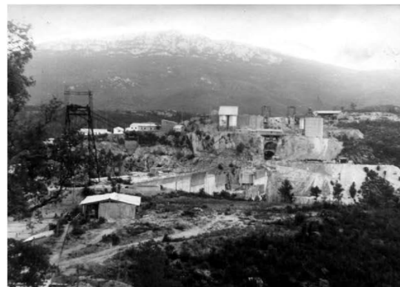
Obr. 2.3.6 Přehrada Boadella ve výstavbě (foto O. Horský 1967)
