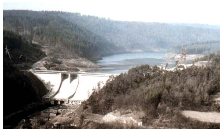
Obr. 2.3.9 Betonová tížní hráz Mohelno (foto O. Horský 1974)
