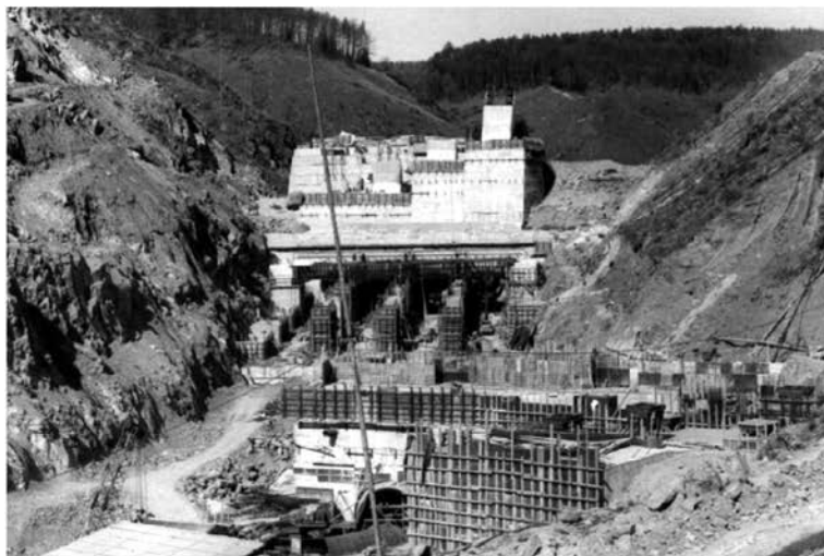
Obr. 2.3.18 Stavba sdruženého betonového objektu kamenité hráze v Dalešicích (foto O. Horský 1978)
