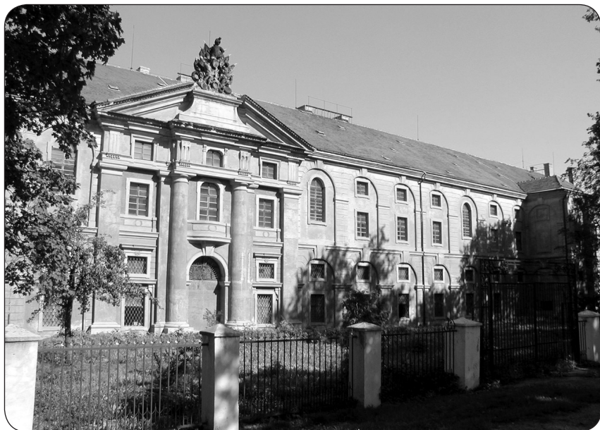
Průčelí Invalidovny v pražském Karlíně
