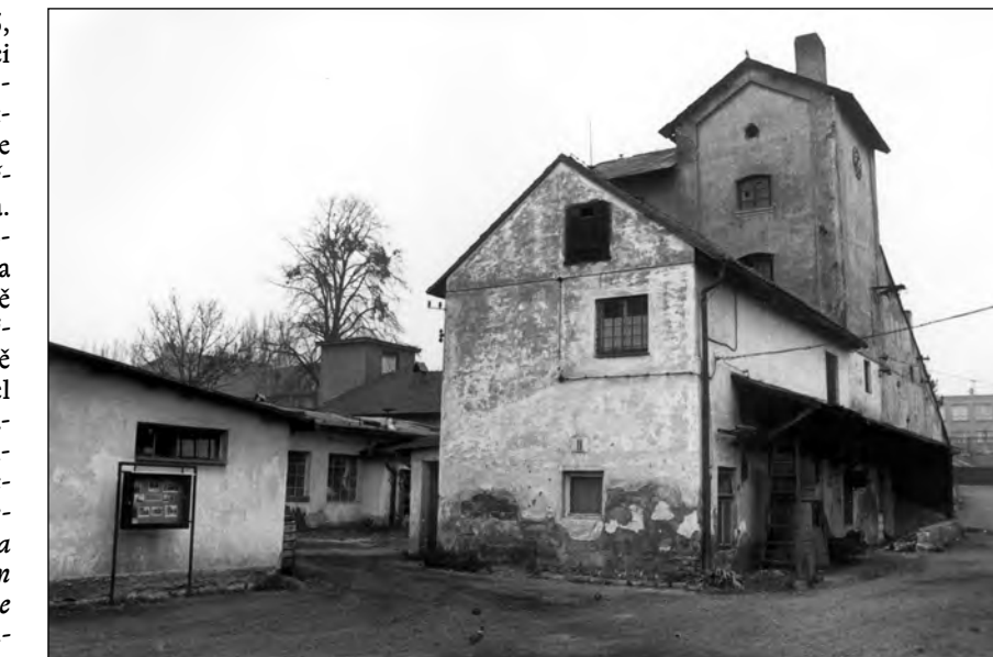
Březnice, zadní pozůstatky městského pivovaru s jím vévodícím věžovitým hvozdem, součástí to při něm se nalézající sladovny (foto autora, 1988).
