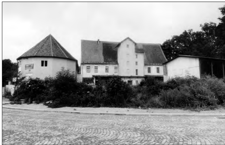
Blatná, zámecké sladovny před panským pivovarem. Uprostřed starší s rizalitním hvozdem pozdější provenience, vlevo mladší zakončená polygonálním uzávěrem. Objekty sloužily i pro provoz cukrovaru a lihovaru (foto autora, 2008).
