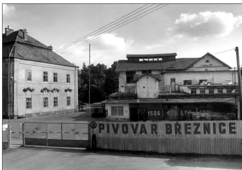
Březnice, zevní pohled na pivovar ještě „předheroldovský“, s upomínkou na tou dobou stále funkční chladičí štok umístěný v podstřeší novějšího provozního celku. Před zmíněnou chladičí (uprostřed) dobře patrný rizalitní výstupek strojního výtahu ze spodních sklepů (foto autora, 1988).
