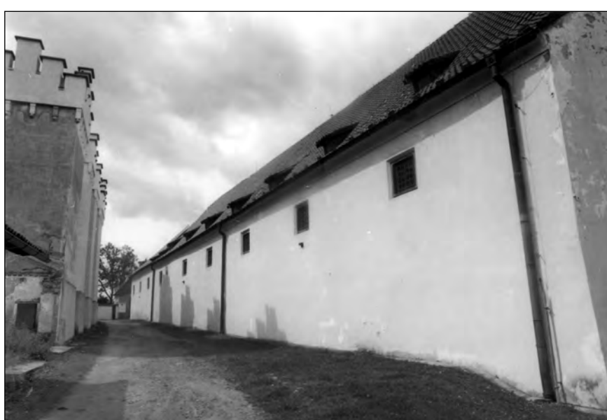
Bechyně, panský pivovar – vpravo pivovarský provoz, vlevo objekt bývalé jízdnary (foto autora, 2004).
