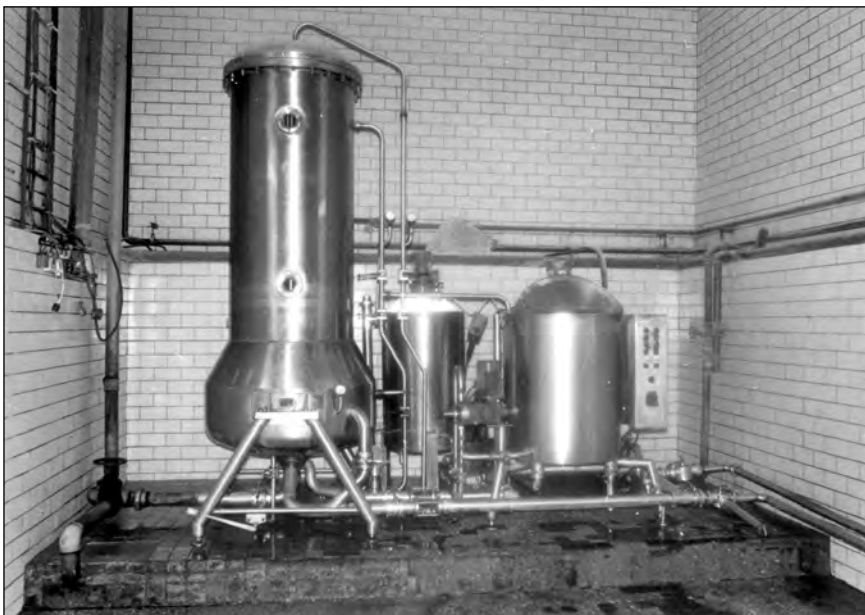
Březnice, filtrační stanice. Jedna z místních modern (foto autora, 2008).
