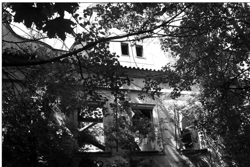
Usedlost Kajetánka v Praze-Břevnové (2008)
