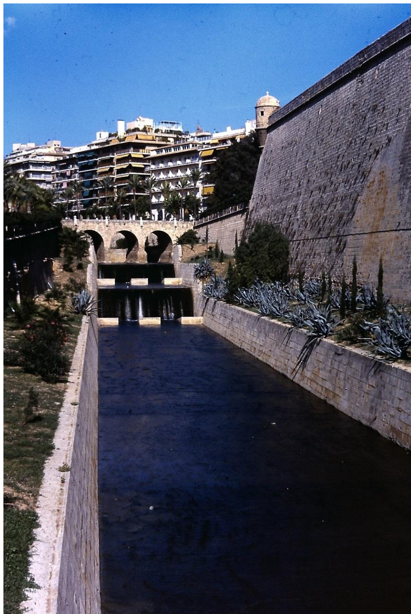
Dodnes plně funkční most v Palmě, postavený Římany.
